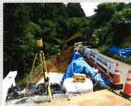
杭ナビ測量機
