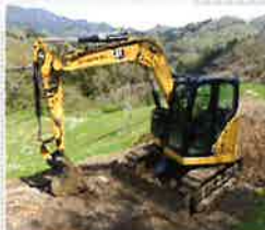
ICT重機作業中
